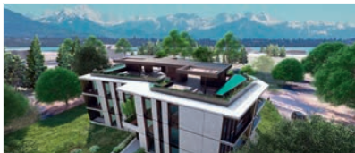
Chambésy - Immeuble en PPE (chantier en cours)
